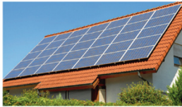
B1 Photoeffekt in Alltag: In einer Solaranlage auf dem Dach eines Wohnhauses wird die Strahlungsenergie der Sonne in elektrische Energie umgewandelt.
